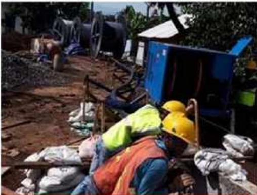
PENARIKAN KABEL POWER 150 KV
