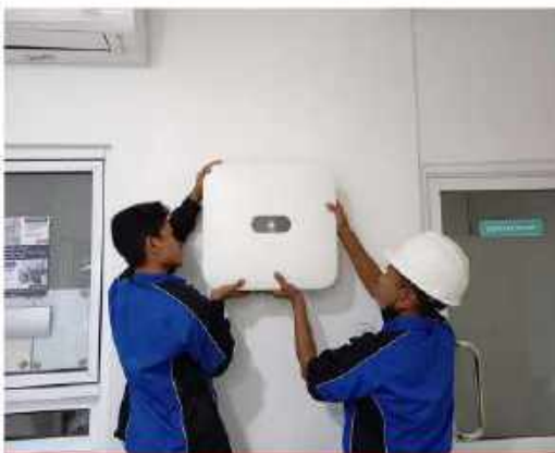
PEMASANGAN INVERTER PLTS
