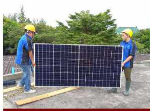
PEMASANGAN PLTS ATAP
