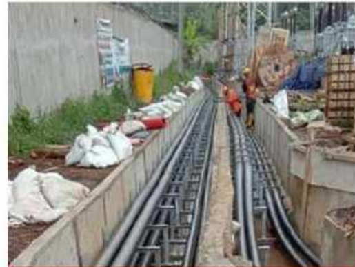
PENEMPATAN KABEL POWER 150 KV
