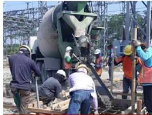
PENGECORAN PONDASI PERALATAN
