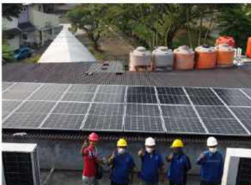
PENGECEKAN PLTS ATAP
