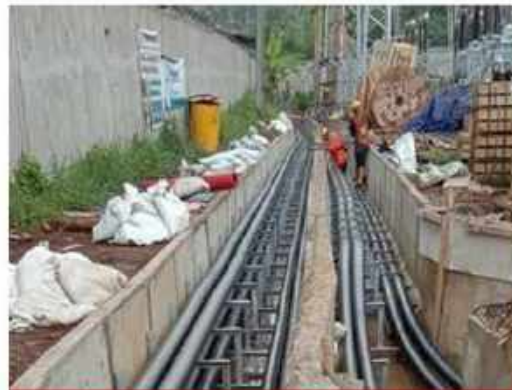
PENEMPATAN KABEL POWER 150 KV
