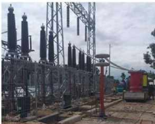
PENGUJIAN HV TEST KABEL POWER
