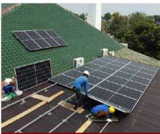
PEMASANGAN PLT ATAP
