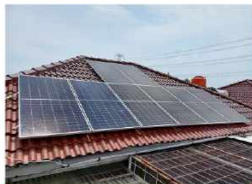
PEMASANGAN PLTS ATAP
