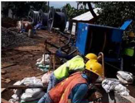
PENARIKAN KABEL POWER 150 KV
