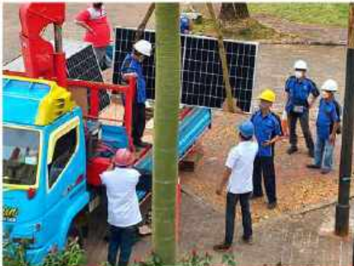
PROSES PEMASANGAN PLTS ATAP
