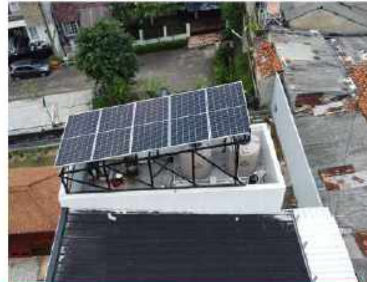
PEMASANGAN PLTS ATAP
