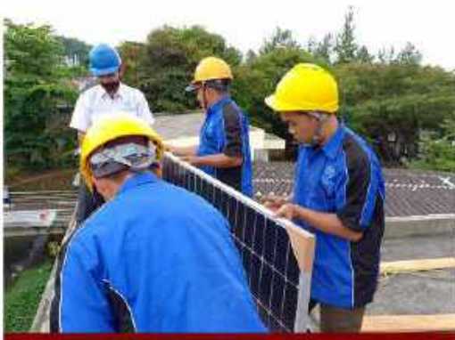
PEMASANGAN PLTS ATAP
