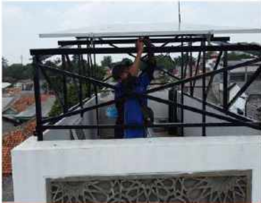
PROSES PEMASANGAN PLTS ATAP
