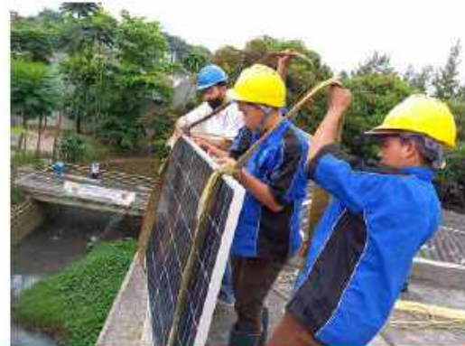
PEMASANGAN PLTS ATAP
