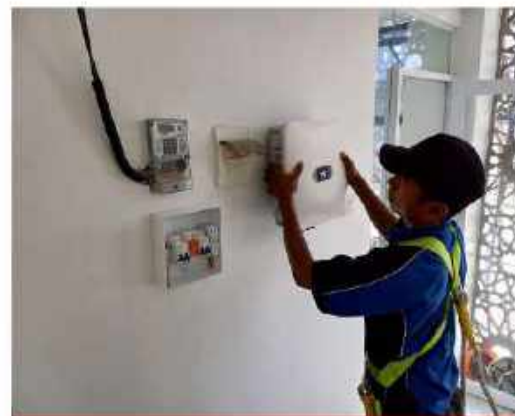
PEMASANGAN INVERTER PLTS
