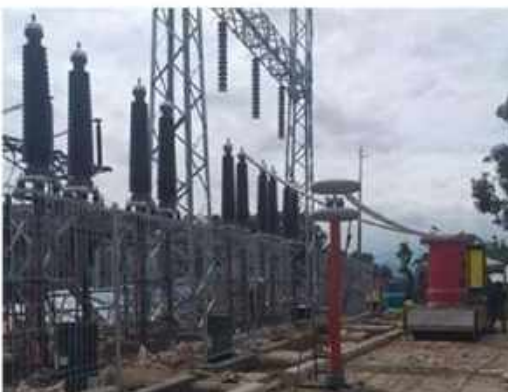
PENGUJIAN HV TEST KABEL POWER
