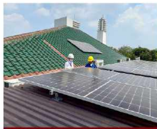
PENGECEKAN PLTS ATAP
